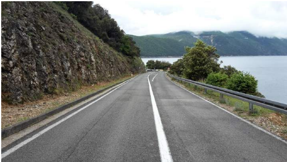
stac. 1+050 gdje počinje treća prometna traka
